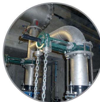
Vanne à guillotine DN 150 avec commande par volant à chaîne plus guide chaîne.
